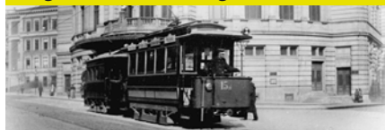
Beginn der Errichtung der Stadtbahn
